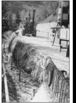
Lavori di viabilità
