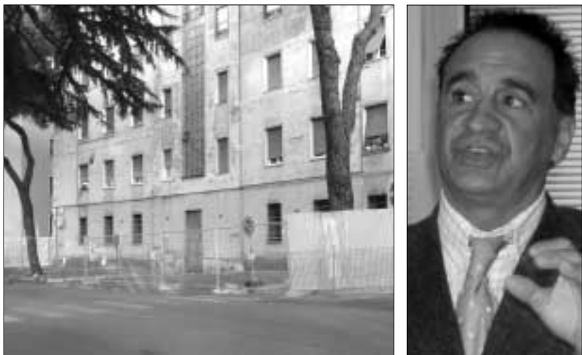
Le transenne collocate lungo corso Garibaldi per l'inizio dei lavori della nuova farmacia. Il presidente Dr. Di Fraia
