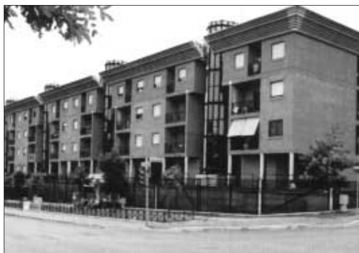
Un'esempio di costruzioni con bioarchitettura realizzato dallo IACP
