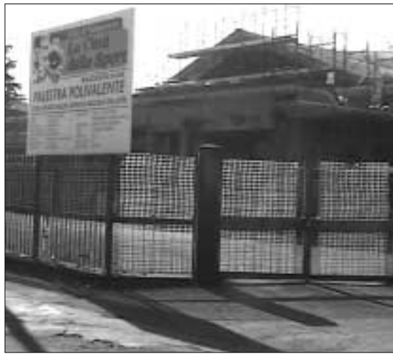
L'area recintata dove sorgerà la Città dello Sport
