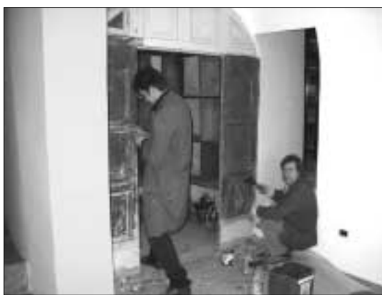
Lavori presso l'archivio storico di Serrone
